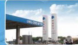
Заправочная станция L-CNG
